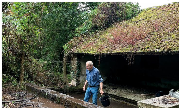
Nettoyage du lavoir à Sur Ocre.
